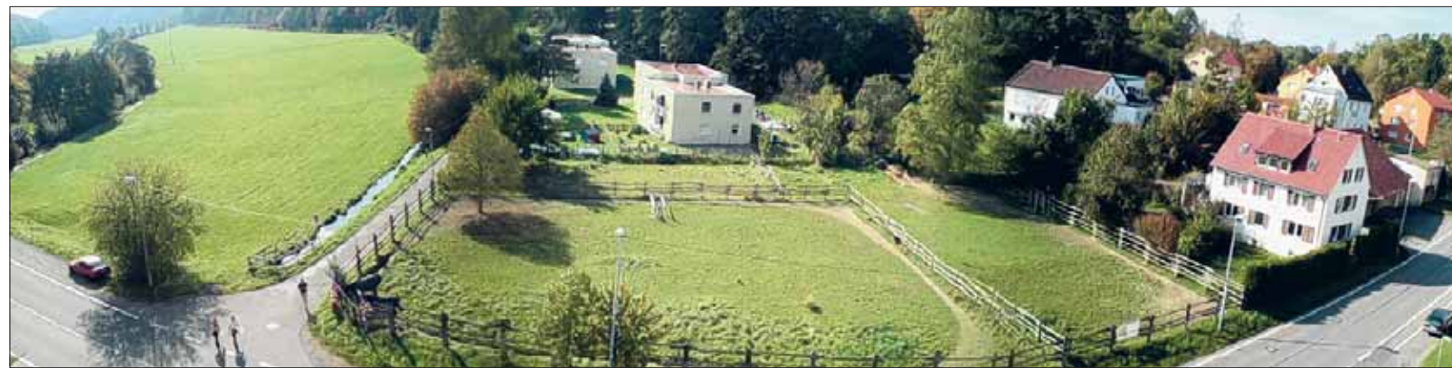
Auf dieser ehemaligen Pferdekoppel errichtet die Firma WinBau die Wohnresidenz Wolfental – direkt am Wolfentalbach.
