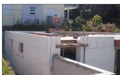
Das Untergeschoss ist komplett mit einer 12 cm starken Wärmedämmung eingepackt, so dass es als vollwertiger Wohnraum genutzt werden kann.
